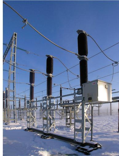
*Interruptor de circuito de desconexión. Los mismos contactos para las funciones de conmutación y desconexión.*
