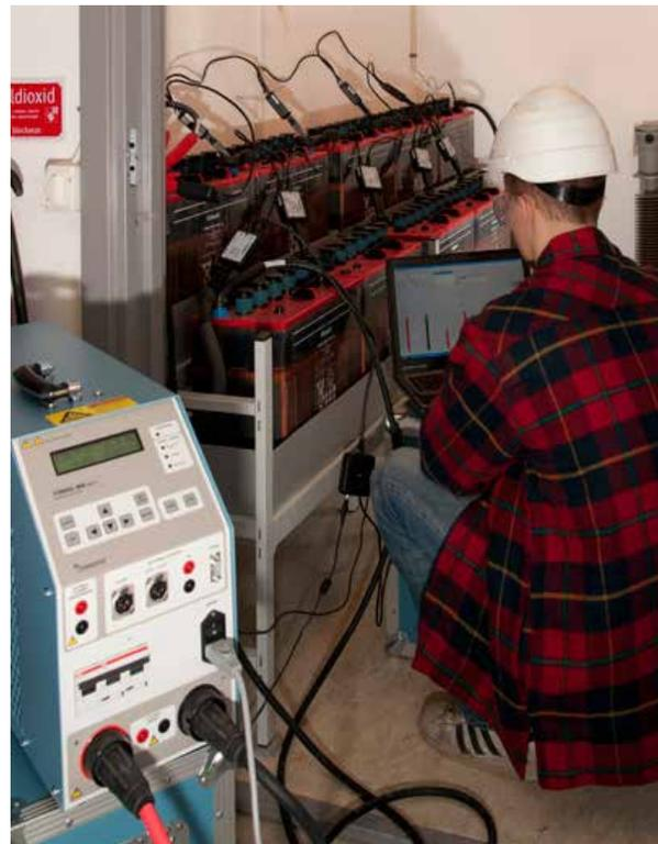
Prueba de baterías con equipo TORDEL
